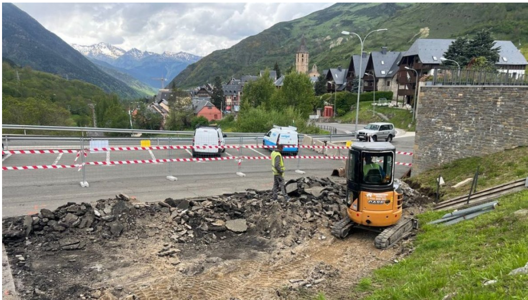
Obres aquest any a Naut Aran per desplegar un sistema de 'district heating'. - AJUNTAMENT DE NAUT ARAN
