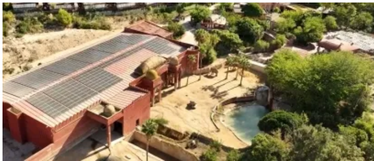
Instalación de autoconsumo de más de 1.000 kW de potencia
