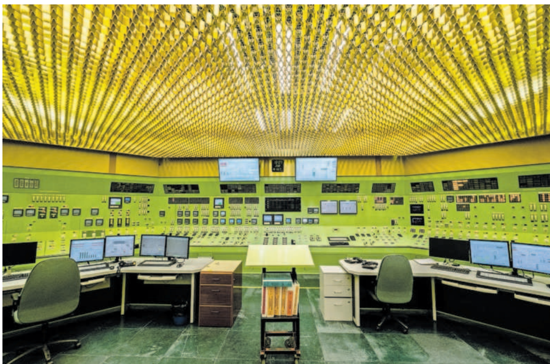
Réplica de la sala de control de la central de Almaraz, que se usa para tareas de formación en la planta. ALEX ONCIU
