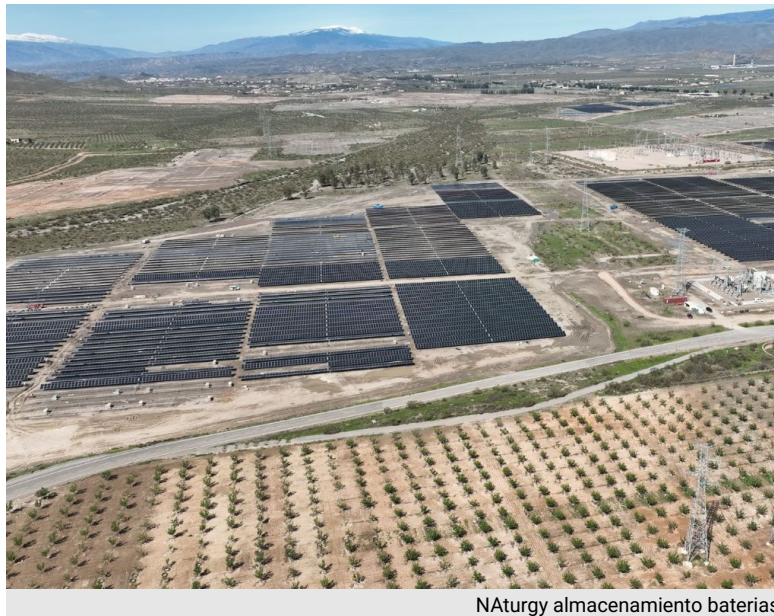
Naturgy almacenamiento baterías
