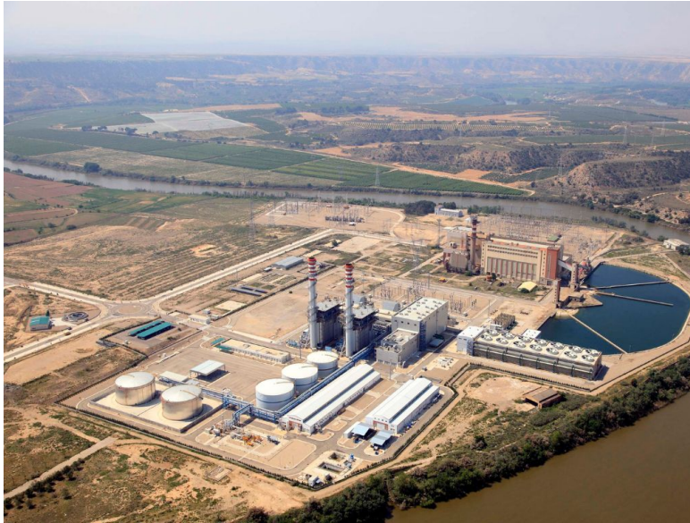
central de ciclo combinado de Repsol en Escatrón (818 MW), Zaragoza
